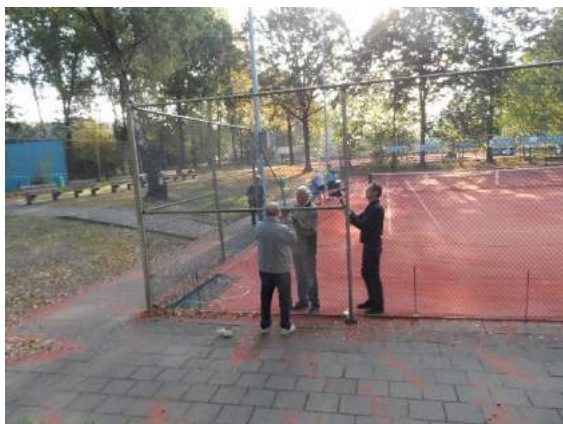
opname van het bevestigen van de nieuwe netophanging
