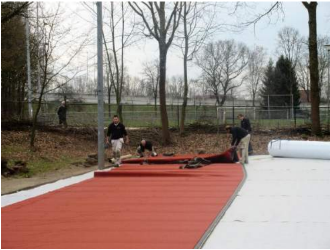
De bovenlaag wordt uitgerold.
