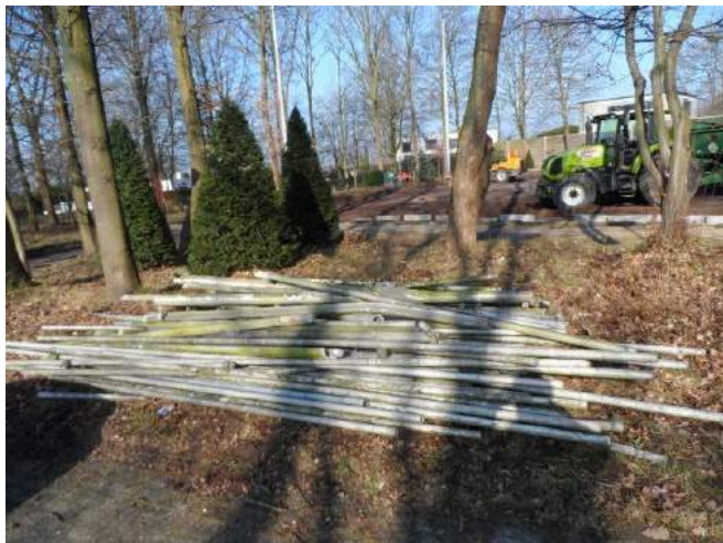
Hier ziet u de losse buizen van het onttakelde hekwerk van baan 3+4 i.v.m. de vernieuwing, (foto van 14 maart 2018).
