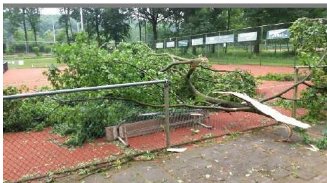
Weet u nog, dit (nood)gevalletje (een van de vele) van stormschade uit 2016 waarbij de omheining (van baan 6) flink beschadigd werd?
