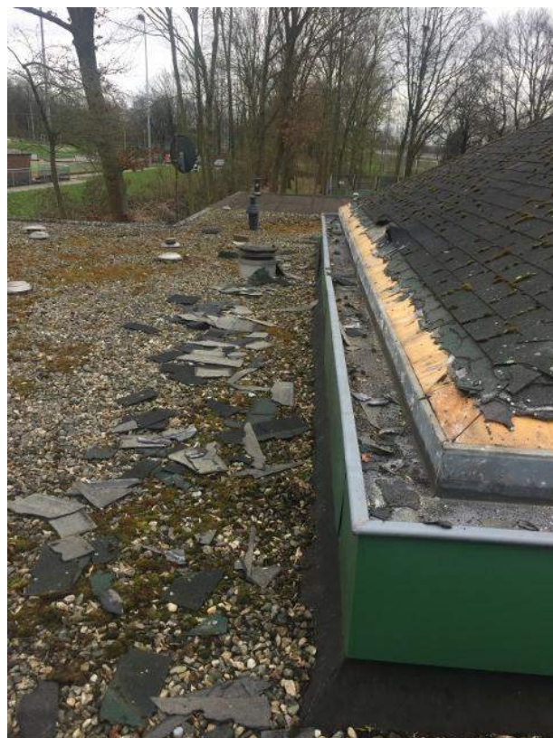
de loodslabben met geweld compleet van het dak gescheurd en daarbij ook de 3 onderste lagen bitumen en singels verwoest
