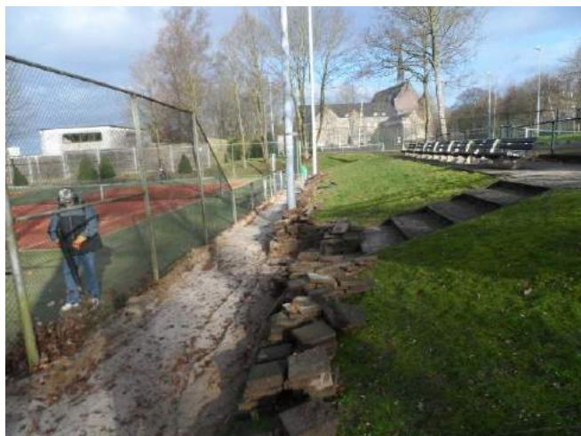
de noordkant, waarbij ook een nieuwe waterafvoer aangelegd is
